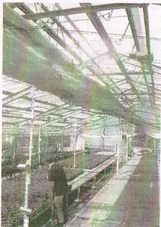
温室の天井近くに張り巡らせたノズル（右上）から細かい霧が噴き出す。愛知県一宮市萩原町、河原田写真
