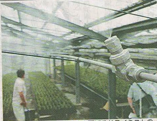
ビニールハウス内の温度を下げるドライミストのノズル。一宮市萩原町萩原の角田ナーセリーで
